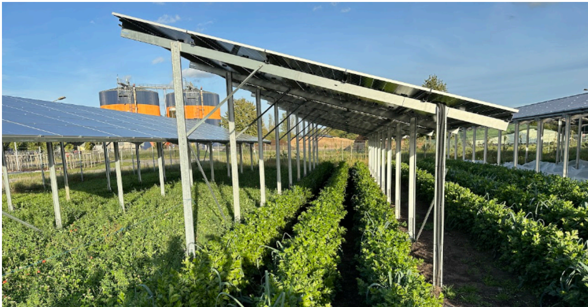
Abbildung 14: Beispiel „Hochaufgeständerte Agri-PV“ (Quelle: Sunfaming)
